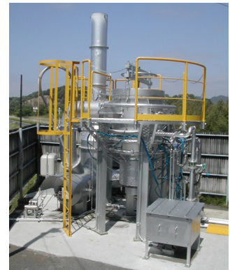
図1 試験設備外観
