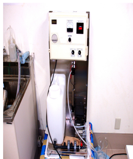
図1：電気分解処理装置
