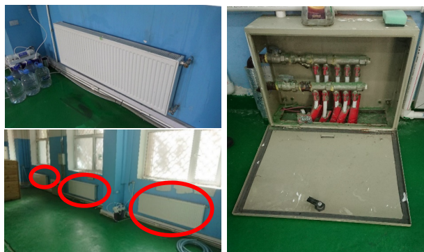
Fig. 1 セントラルヒーティング (左：放熱器，右：蒸気の流量調節バルブ)
